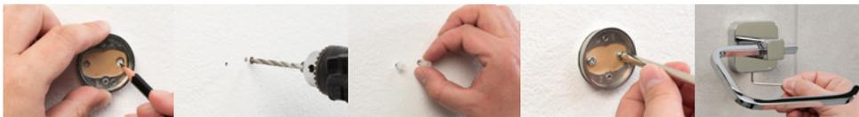
1. Bohrlöcher markieren 2. Bohren 3. Dübel setzen 4. Adapter montieren 5. Accessoire montieren.
